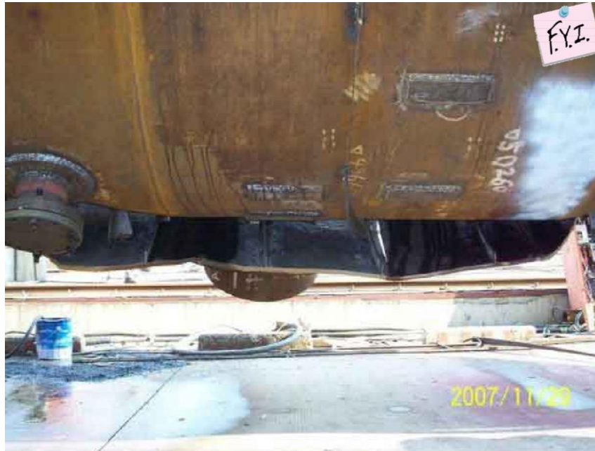
شکست ترد یک ظرف تحت فشار در زمان تست هیدرواستاتیک
